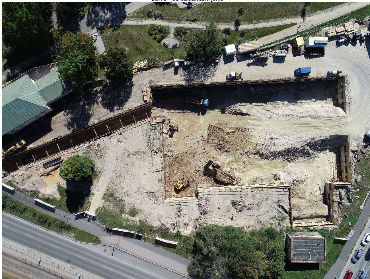
Obr. 6 – SO 01 stavební jáma
