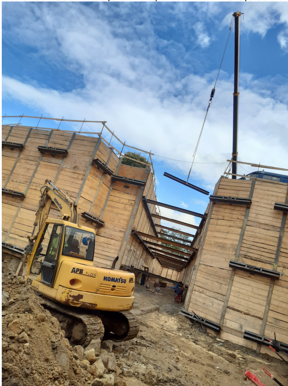
Obr. 3 – SO 04 odtěžování na třetí rozpěrnou úroveň odpadní stoka DN 1600 + montáž rozpěrného rámu
