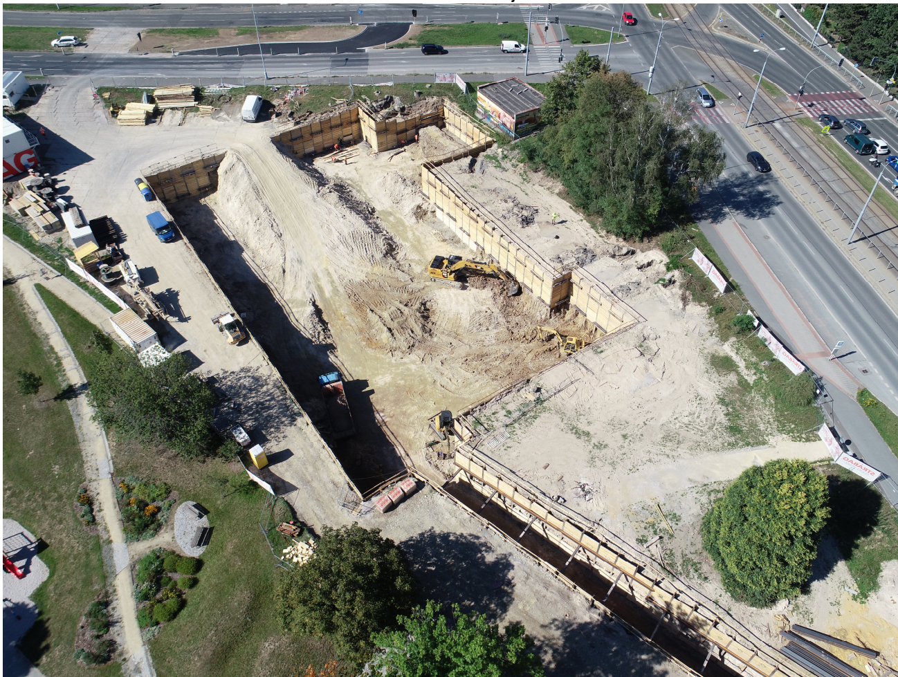
Obr. 4 – SO 01 stavební jáma
