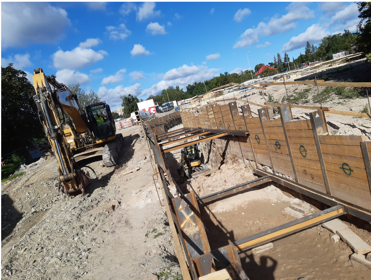
Obr. 1 – Výkop pro – SO 04 odpadní stoka DN 1600
