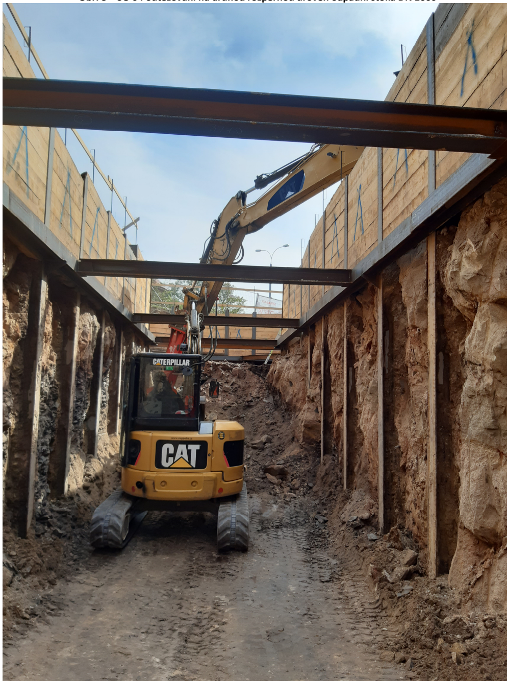
Obr. 3 – SO 04 odtěžování na druhou rozpěrnou úroveň odpadní stoka DN 1600
