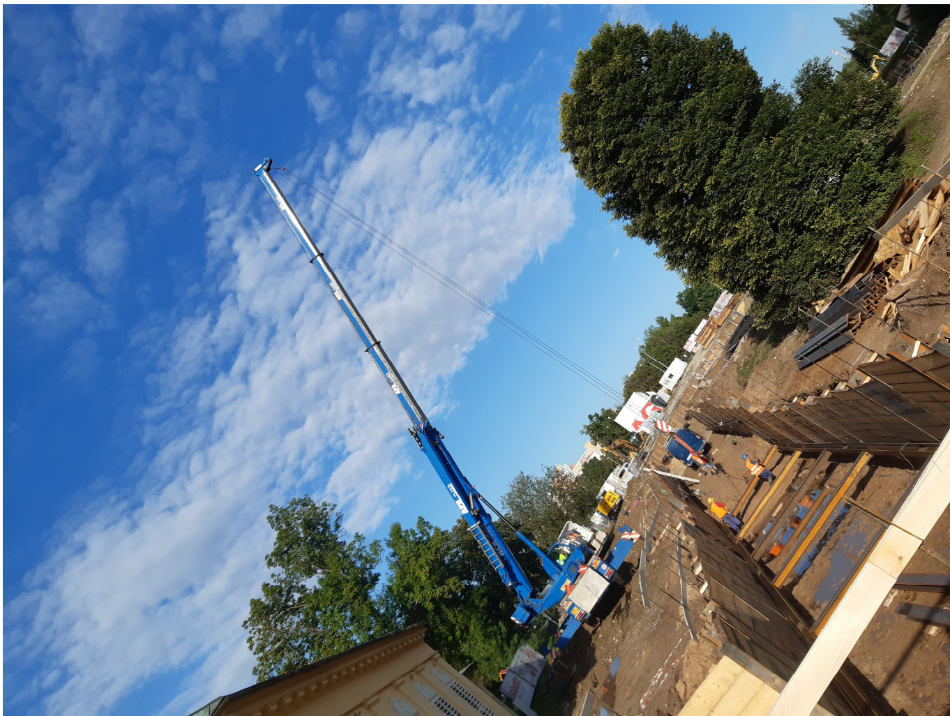
Obr. 1 – Montáž rozpěrného rámu – SO 04 odpadní stoka DN 1600
