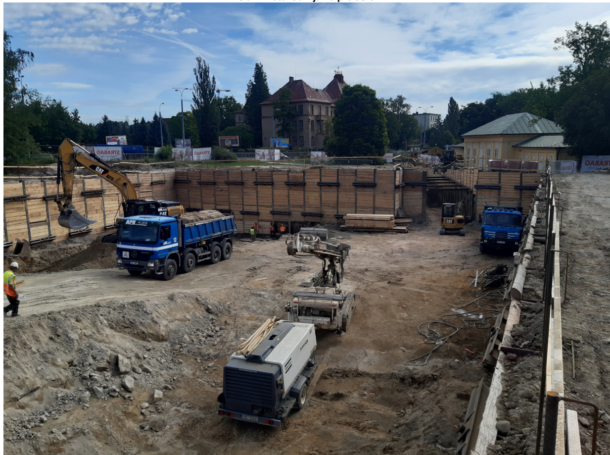
Obr. 2 –Stavební jáma pro SO 01
