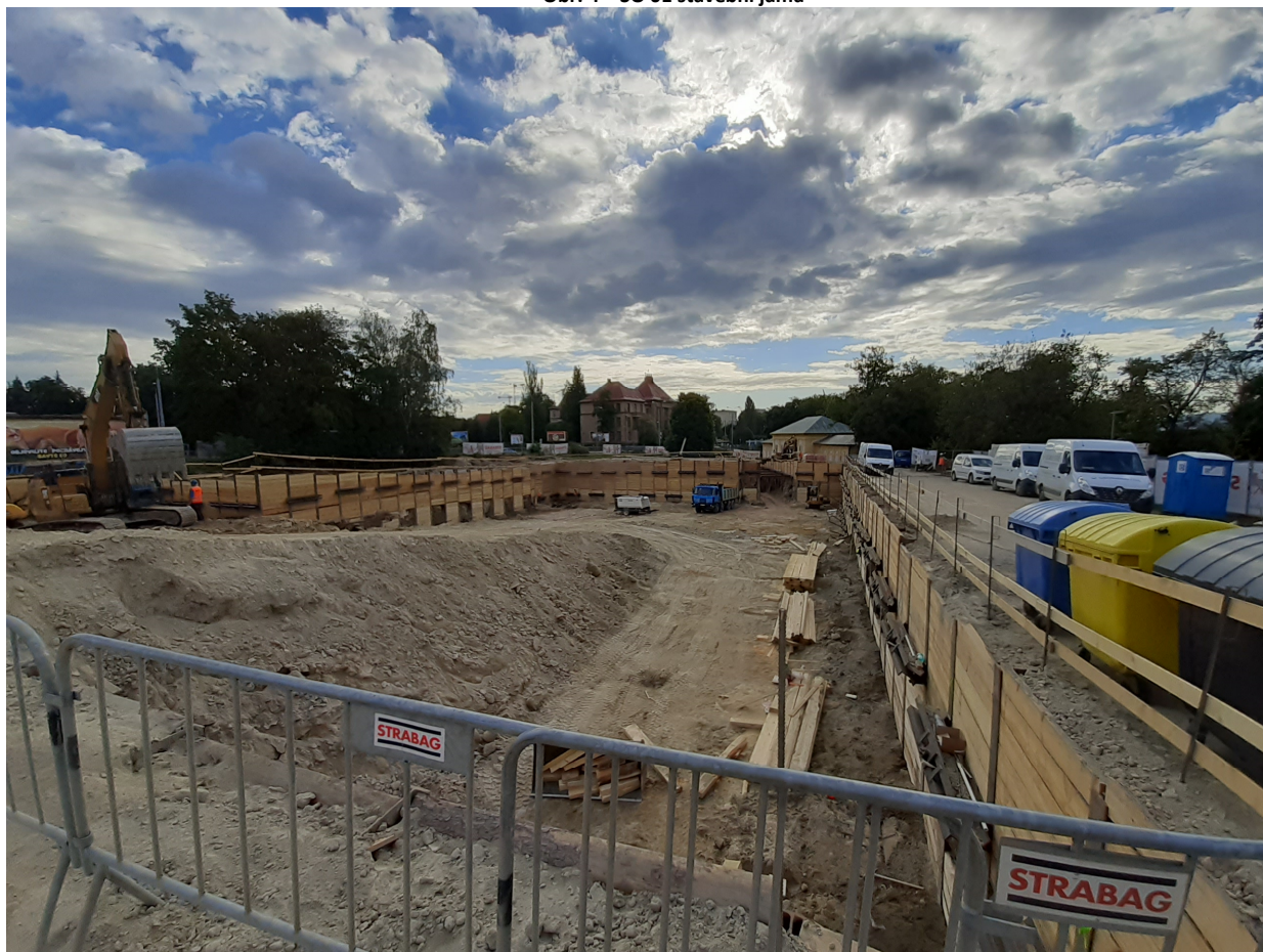
Obr. 4 – SO 01 stavební jáma
