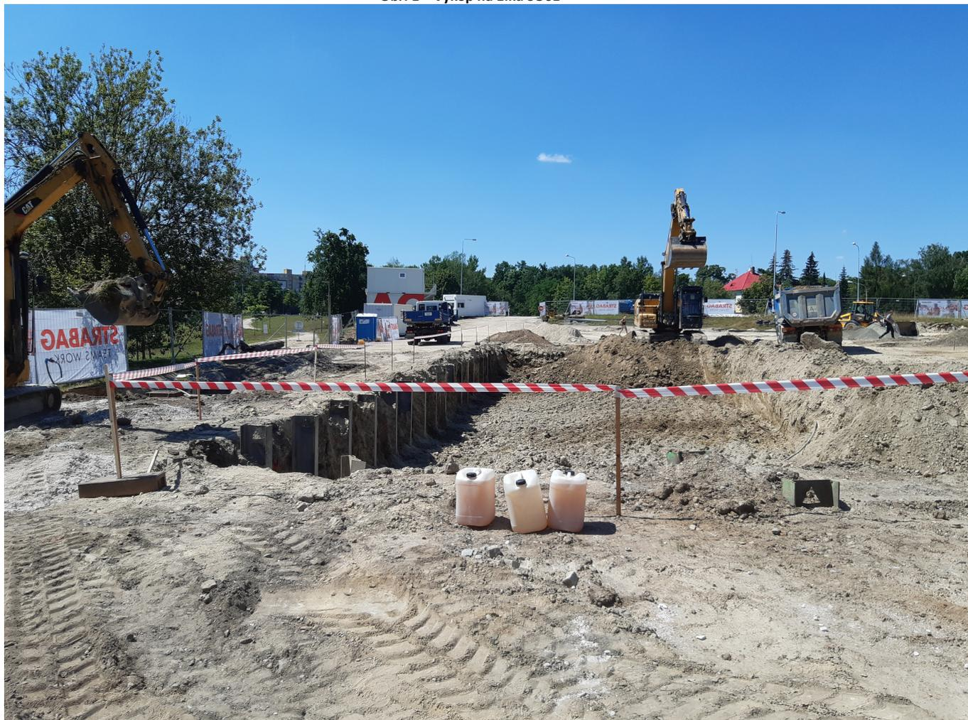
Obr. 2 – Vrtání + osazování zápor SO 03, výkop SO 01 -1.kú
