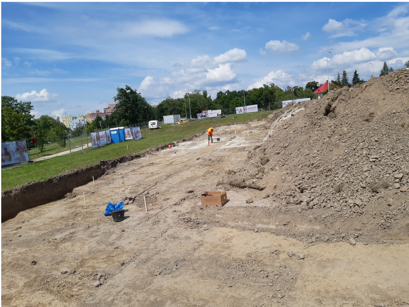
Obr. 2 – Provádění archeologického dohledu/ výzkumu v ploše SO 01
