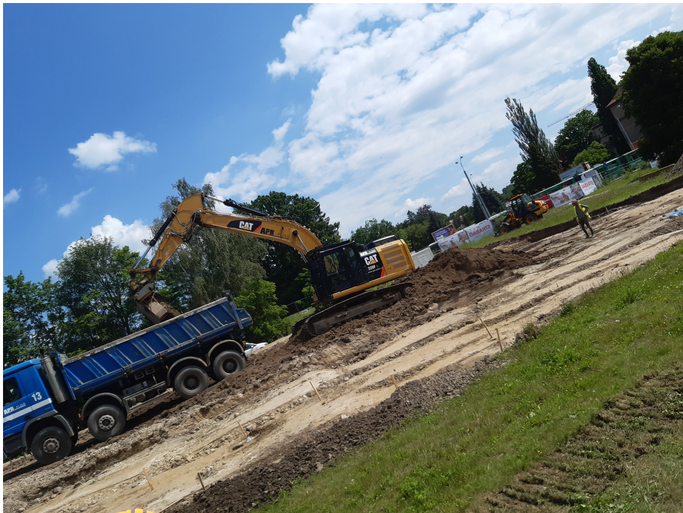
Obr. 3 – Skryvka a odvoz ornice v ploše SO 01
