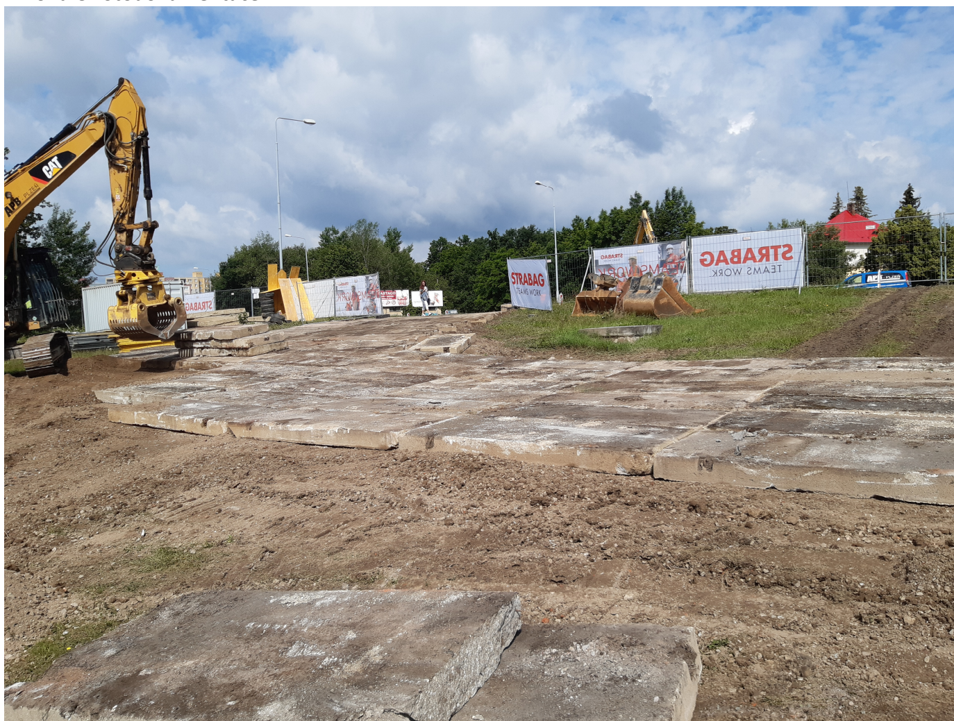
Obr. 1 – Pokládka staveništní panelové komunikace
